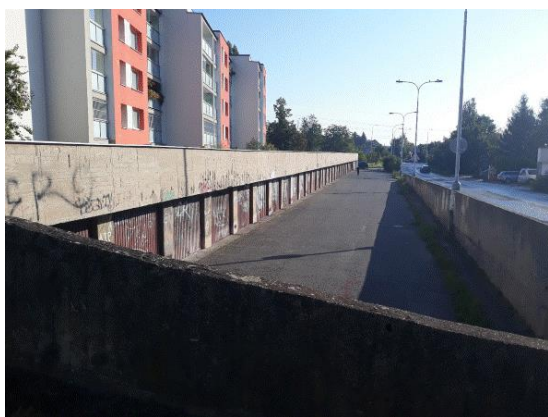
Obrázek 31 - Garáže při ulici Slévačská_1
