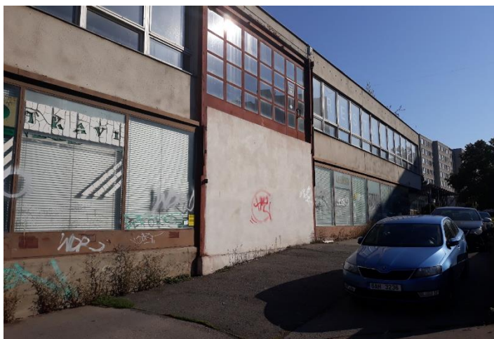
Obrázek 15 - Nevyužívané nebytové prostory v ulici Kardašovská_2
