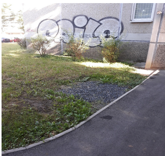
Obrázek 11 - Nesprávné řešení ochrany před přívalovými dešti_1 (v blízkosti obytného domu Rochovská 496)
