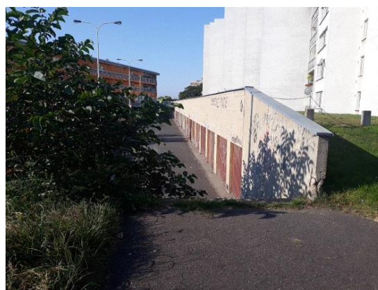
Obrázek 32 - Garáže při ulici Slévačská_2
