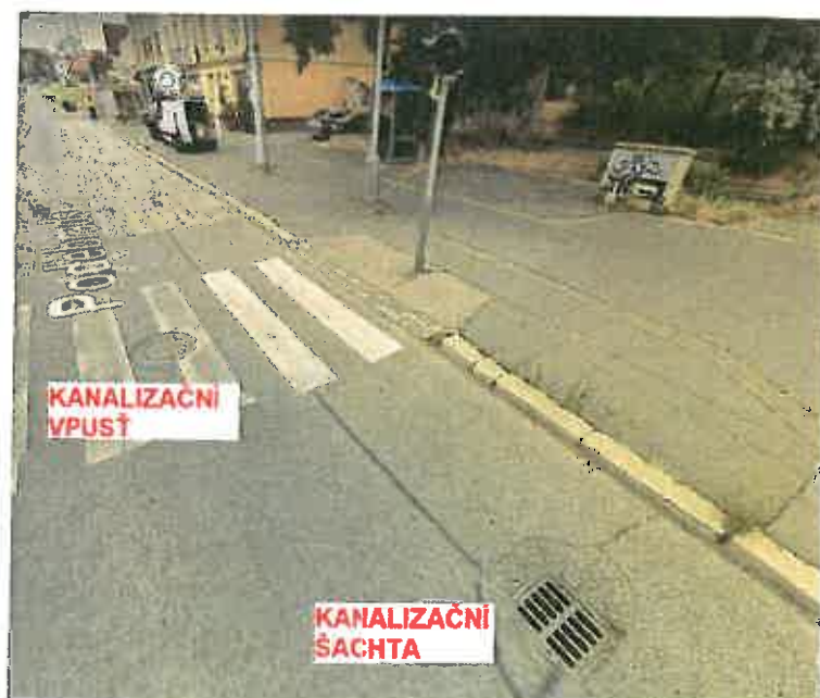
Obrázek 46: kanalizační vpusť a kanalizační šachta na fotce z Google Street View (ulice Poděbradská 50.1050047N, 14.5320153E)
