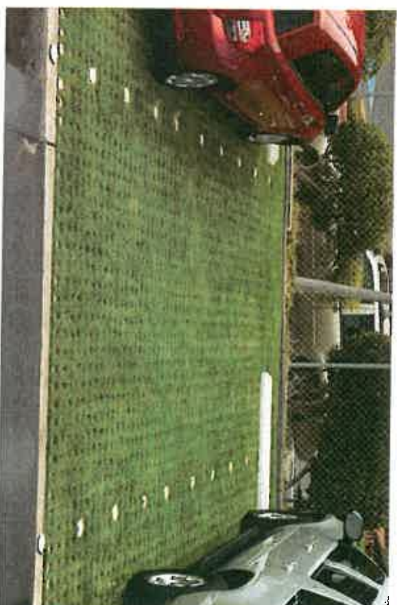
Zatravnňovací tvárnice Guttagarden – realizace ( https://www.guttagarden.cz/zatravnovaci-tvarnice-guttagarden-7809/ )
